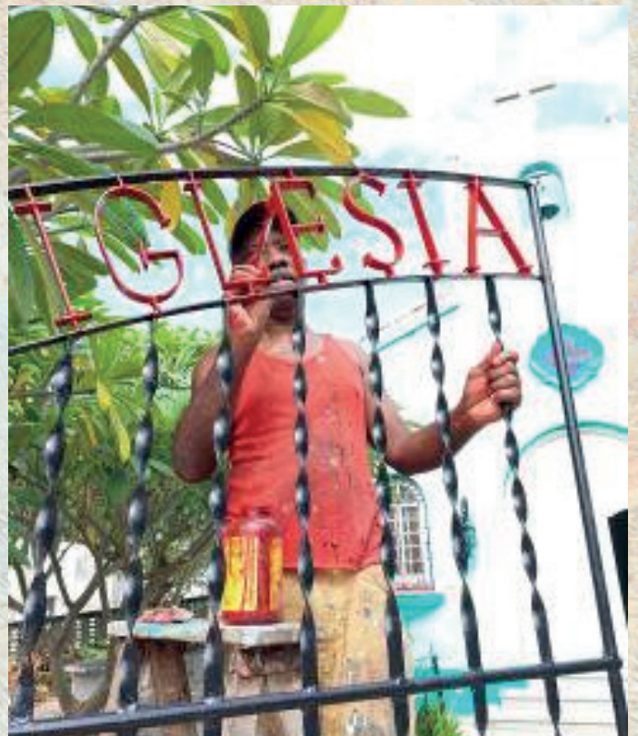
Segno di vita... abbiamo dipinto la chiesa. E anche la inferriata con dei bei colori
